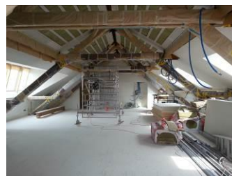
Leonhard Gym, Dachstock
