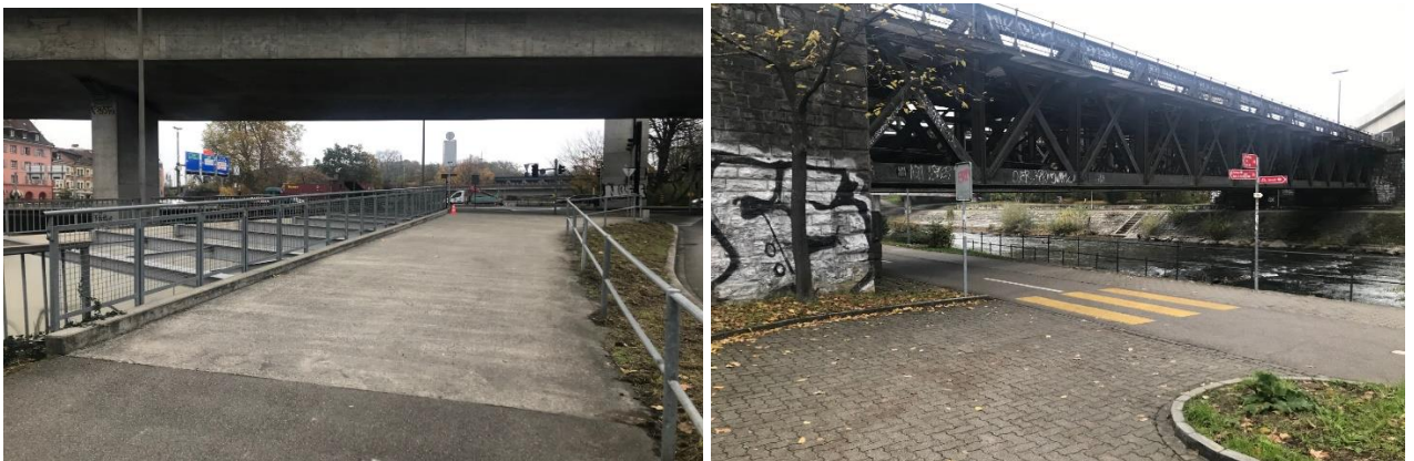
Abb. 29 und 30: Provisorische Überdeckung Mauerstrasse und Kreuzungssituation am Uferweg Wiese
