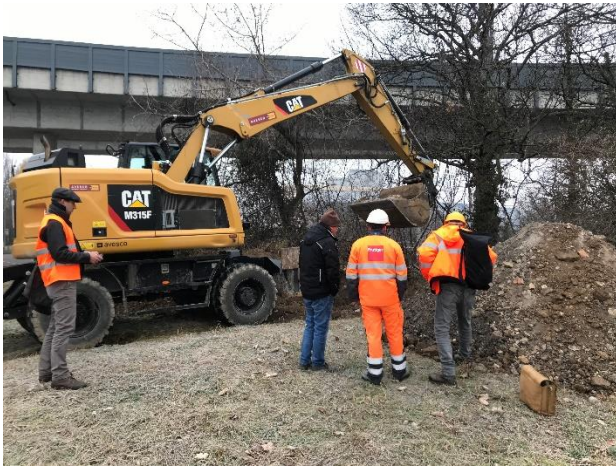
Abb. 26 und 27: Sondagen zur Untersuchung des Bodenmaterials
